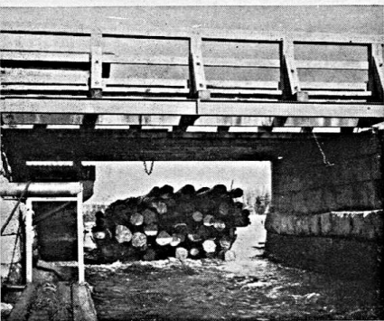
Miekankoskella niput pujahtavat vedessä kulkevan vaunun siirtämänä tällaisesta neulansilmästä Juolasveden puolelle (aik.)
